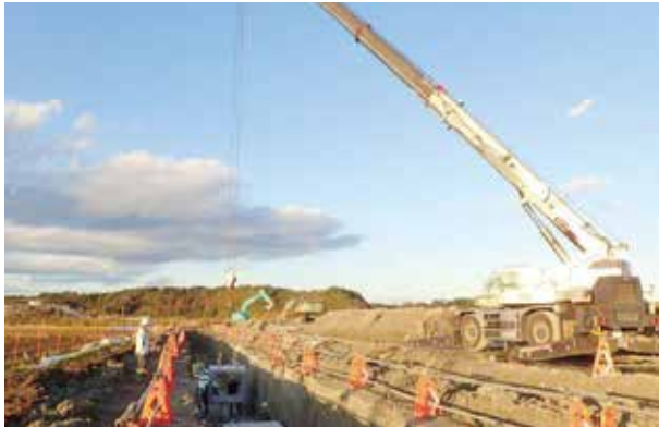
ボックスカルバート（内空幅1.3m×内空高1.2m）布設
