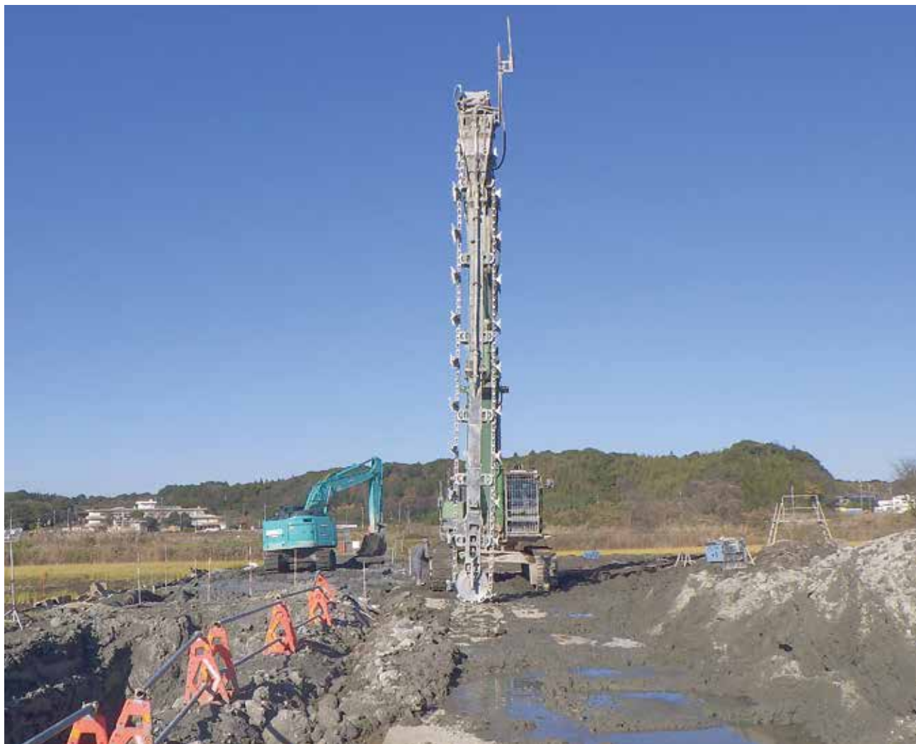
小森揚水機場導水路地盤改良工事 (パワーブレンダー工法)
